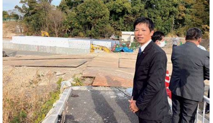
御殿山小倉線工事進捗視察 (12月6日)
